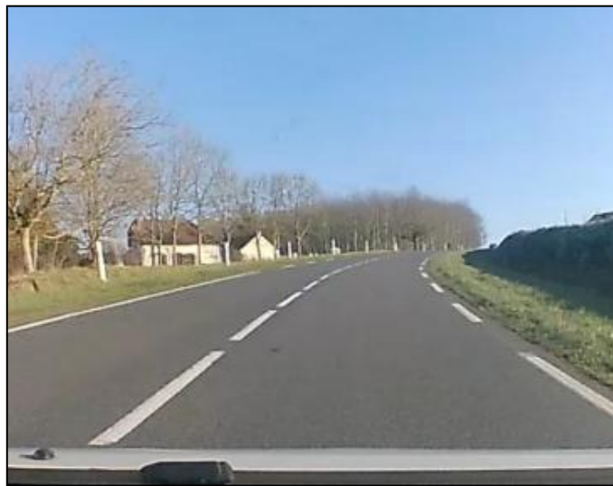
Figure 53 : Vue de la D32 en amont de la plateforme (Source : CDVIA, 2019)
